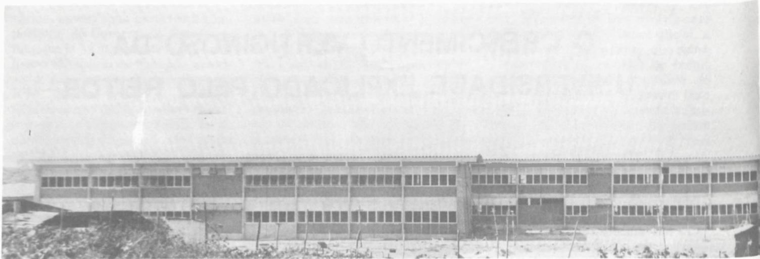
O Campus terá 103 mil metros quadrados de área construída
