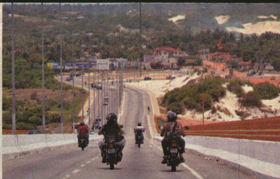
Acessos para a Ponte Newton Navarro, inaugurada em novembro de 2007, ainda não foram feitos
