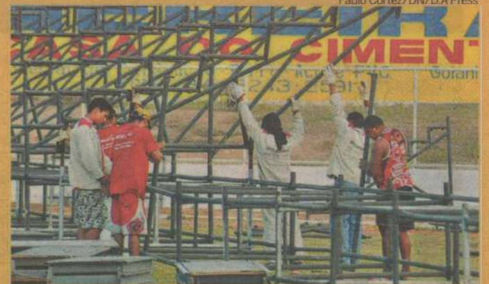
Arquibancadas tubulares aumentarão a capacidade do estádio Nazarenão
