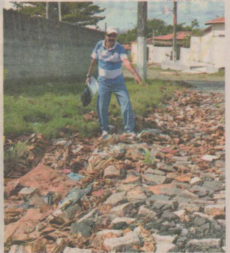
Em mau estado de conservação, Rua da Macieira é uma das principais vias locais
