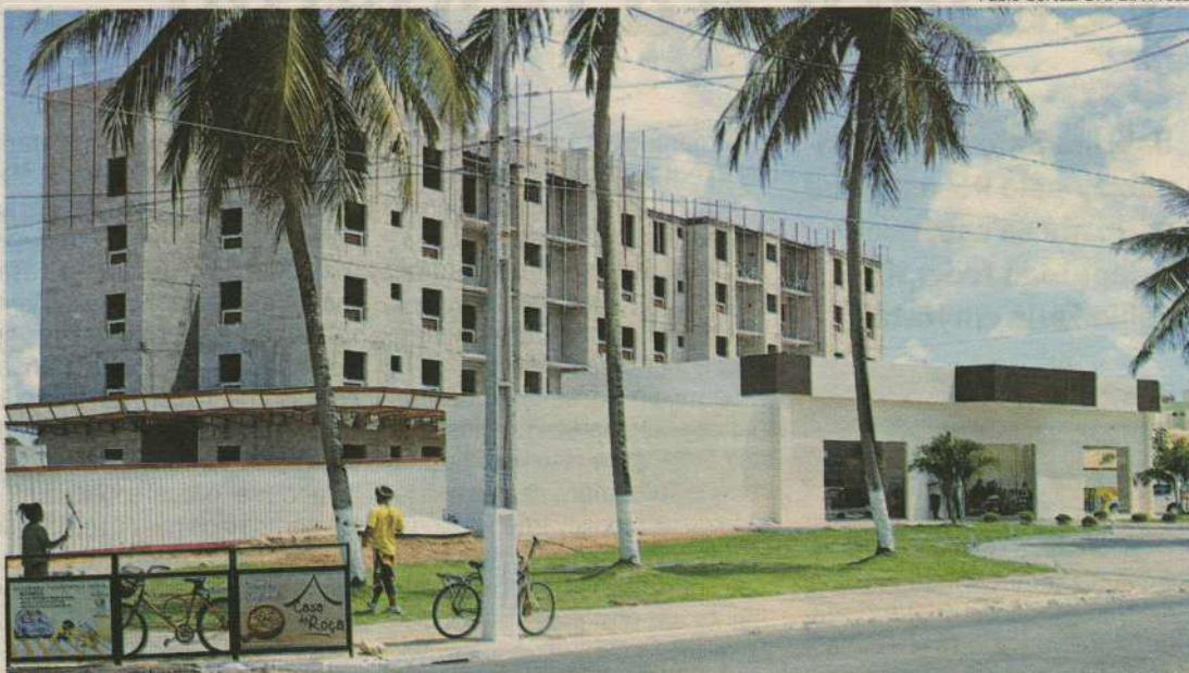
Prédio em construção no bairro de Nova Parnamirim, uma das áreas mais procuradas pela classe média na Grande Natal
