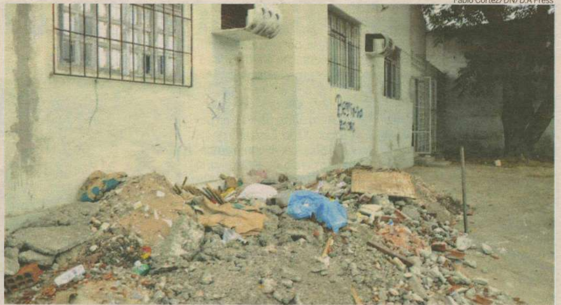
Prédio localizado no bairro da Ribeira está interditado para a realização de melhorias na estrutura física
