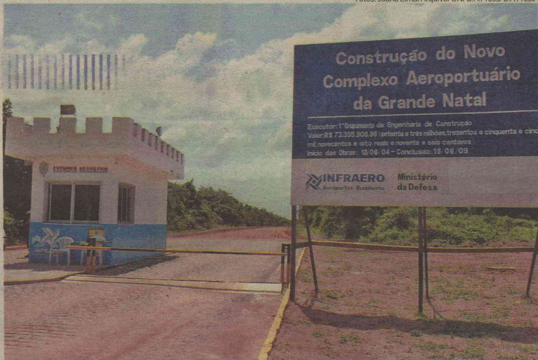
Obras do terminal já tiveram início e, até hoje, foram investidos cerca de R$ 160 milhões
