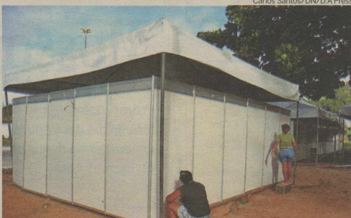
Estandes estavam sendo montados ontem à tarde no Campus Central
