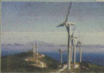
no setor de energia renovável. Turbinas eólicas
