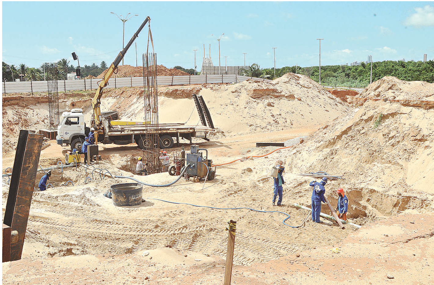
// Obra do viaduto da Redinha inserida no Pro-Transporte, na Zona Norte, deve ser entregue até o final deste ano
