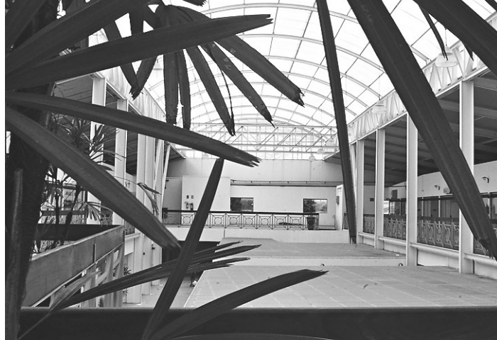
// Mercado ainda recebe obras de climatização e canalização de gás
